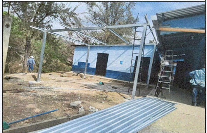
Foto 4: Área donde se esta instalando la galera de cocina
