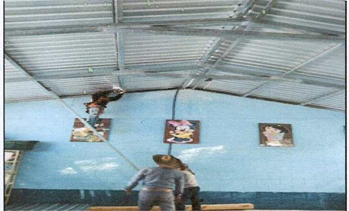
Foto 2: Área donde se esta instalando la energía electrica
